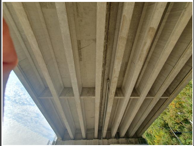
거더 및 가로보 전경
